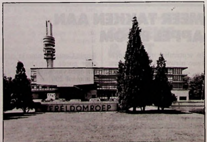
Het gebouw van de Wereldomroep in Hilversum.
